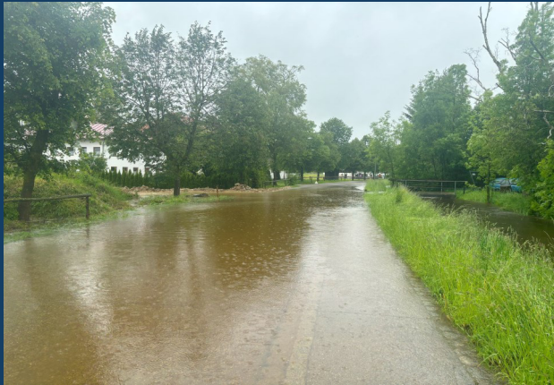
Ortsdurchfahrt Salenwang ist überflutet
